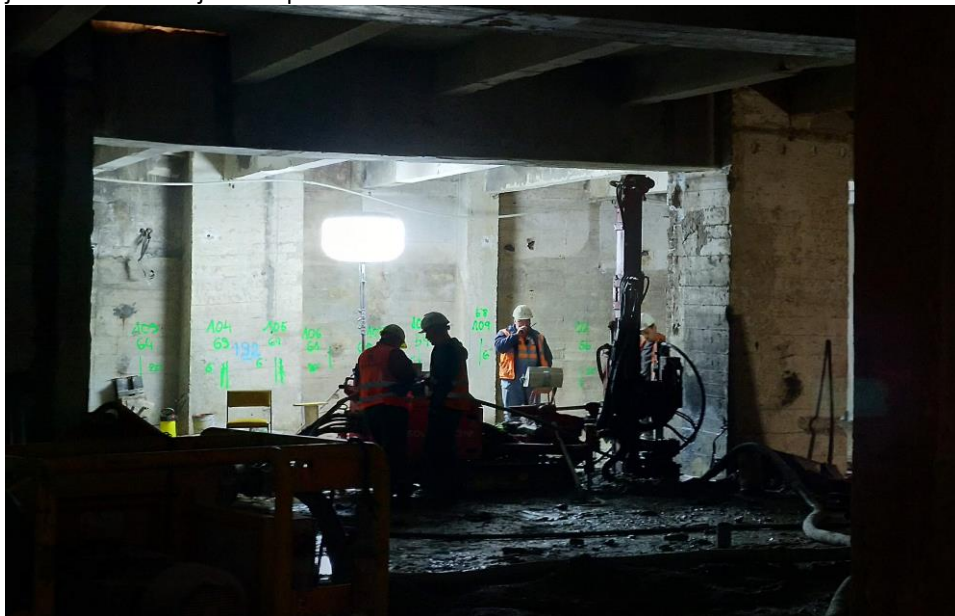
Realizace pilířů tryskové injektáže a mikropilot v interiéru objekt
