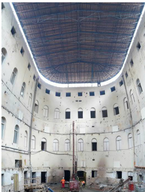
Realizace pilířů tryskové injektáže a mikropilot v interiéru objektu
