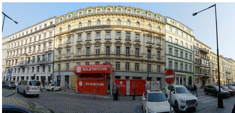
Zařízení staveniště a rekonstruovaný objekt
