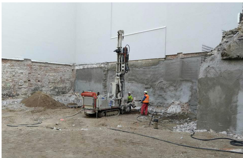
Realizace pilířů trykové injektáže
