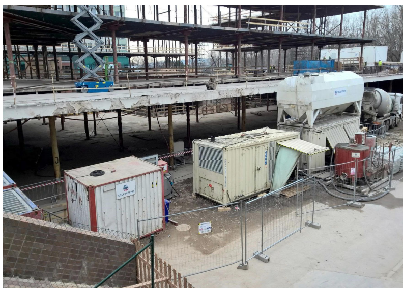
Zařízení staveniště pro trykovou injektáž u rekonstruovaného objektu.
