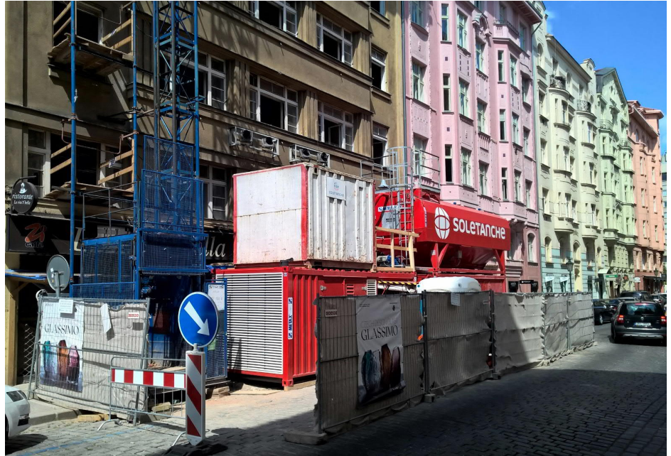
Zařízení staveniště pro tryskovou injektáž
