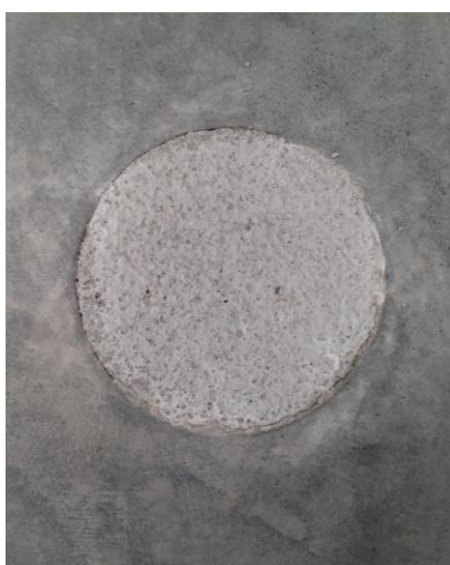
Detail průvrtu podlahou po tryskové injektáži a začištění.
