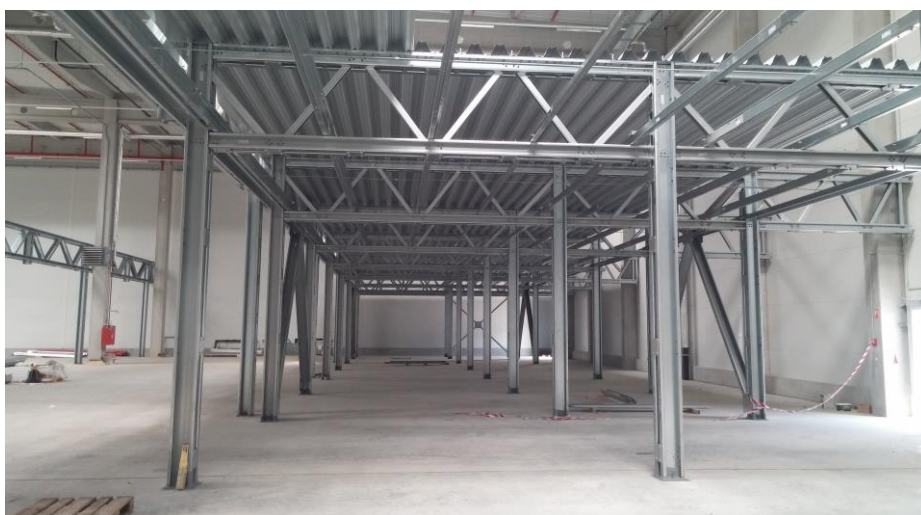
Hala v průběhu realizace vestavby.
