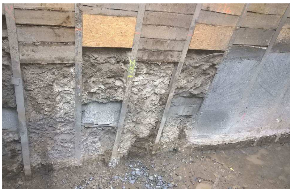
Zajištění jámy těsněnou záporovou stěnou
