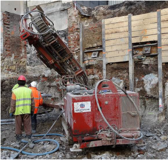
Kotvení pažících stěn
