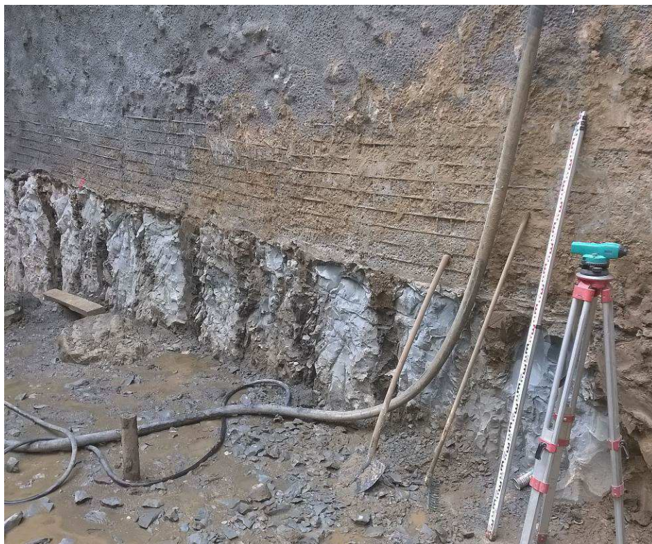
Podchycení objektu trykovou injektáží
