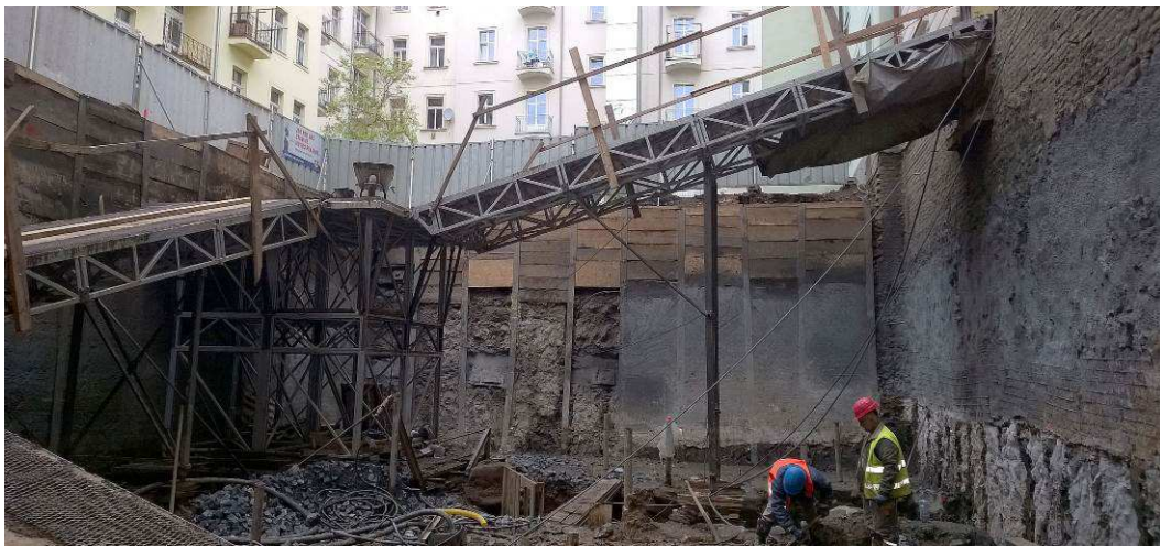
Těžba stavební jámy
