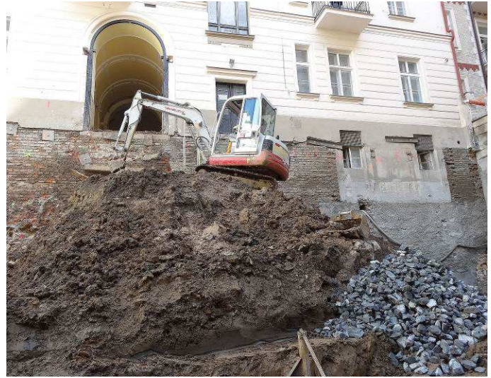
Těžba stavební jámy
