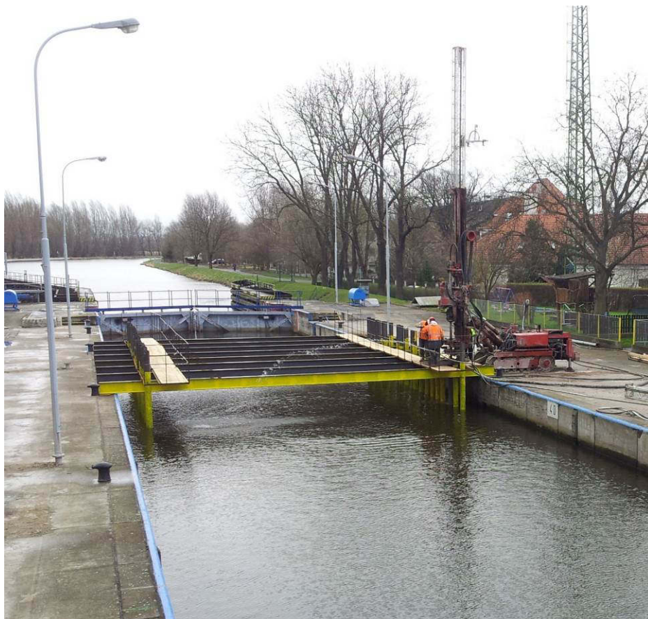
Realizace trykové injektáže pod dnem PK (pod hladinou vody)
