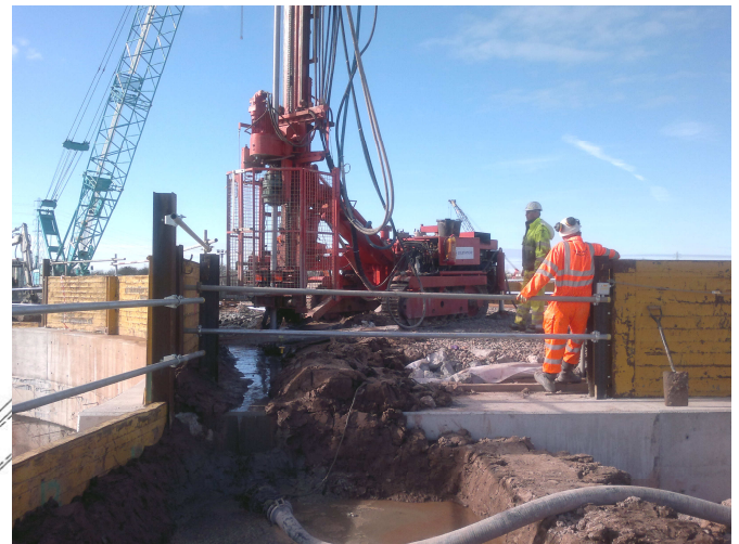
Provádění trykové injektáže
