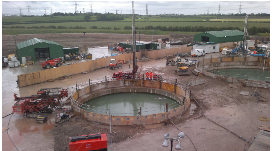
Pohled na čerpací šachty
