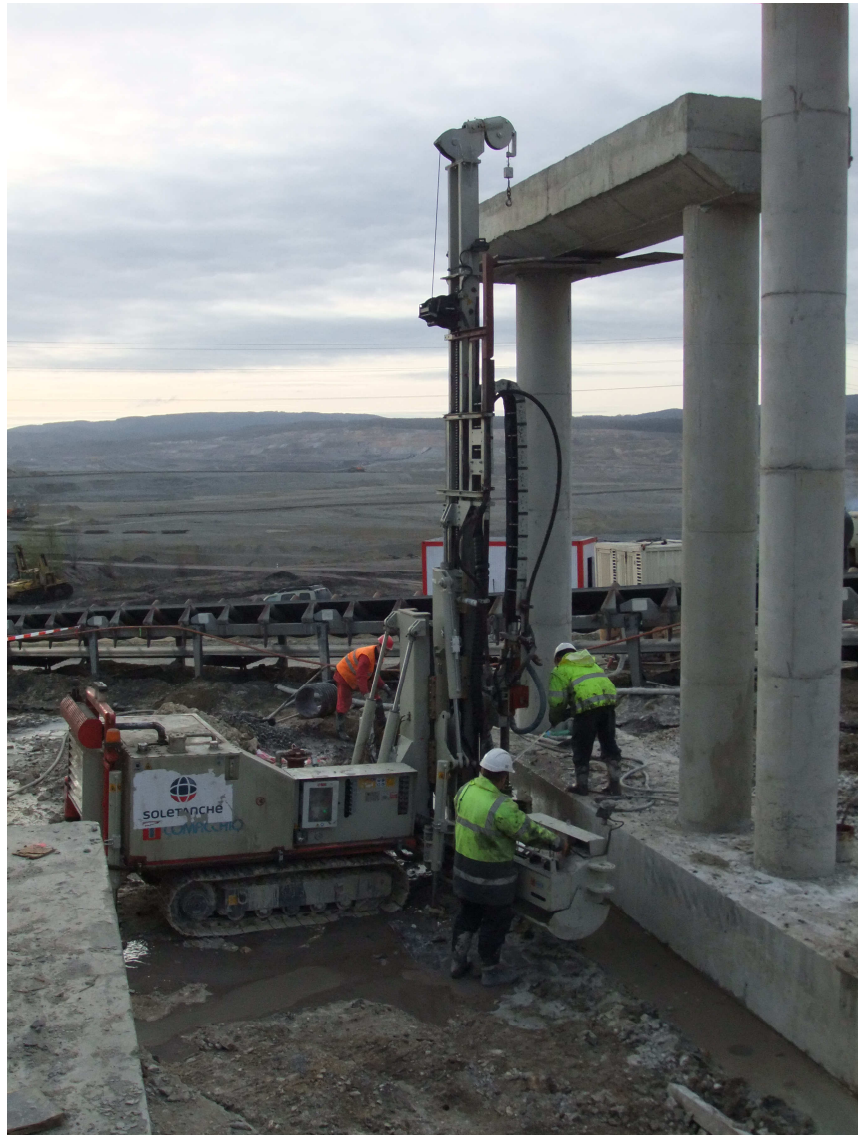
Provádění trykové injektáže pod základovou patkou
