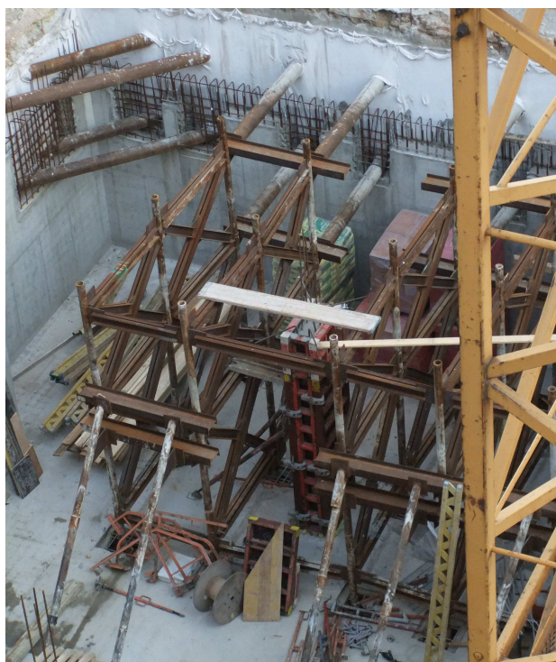
Realizace ocelových bářek
