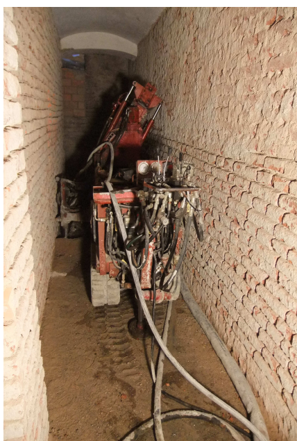
Provádění trykové injektáže uvnitř objektu
