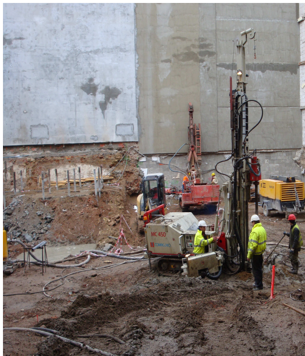
Provádění trykové injektáže – nasazení dvou vrtných souprav v dvorním traktu
