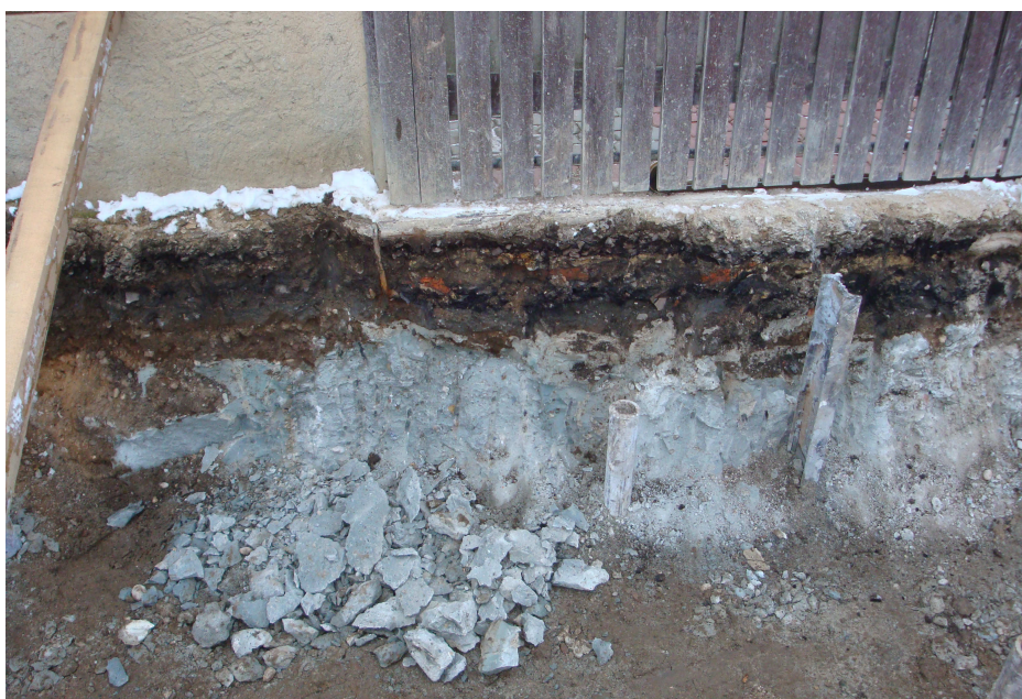
Trysková injektáž provedená pod základem plotu v blízkosti budoucí PPO
