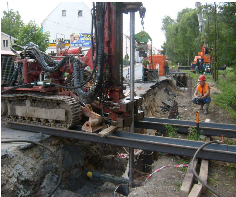
Provádění tryskové injektáže v místě prostupu inženýrských sítí
