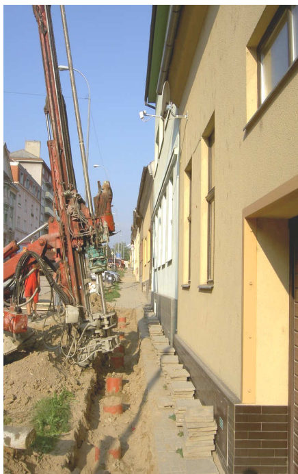
Provádění trykové injektáže – podchytávání stávajících objektů
