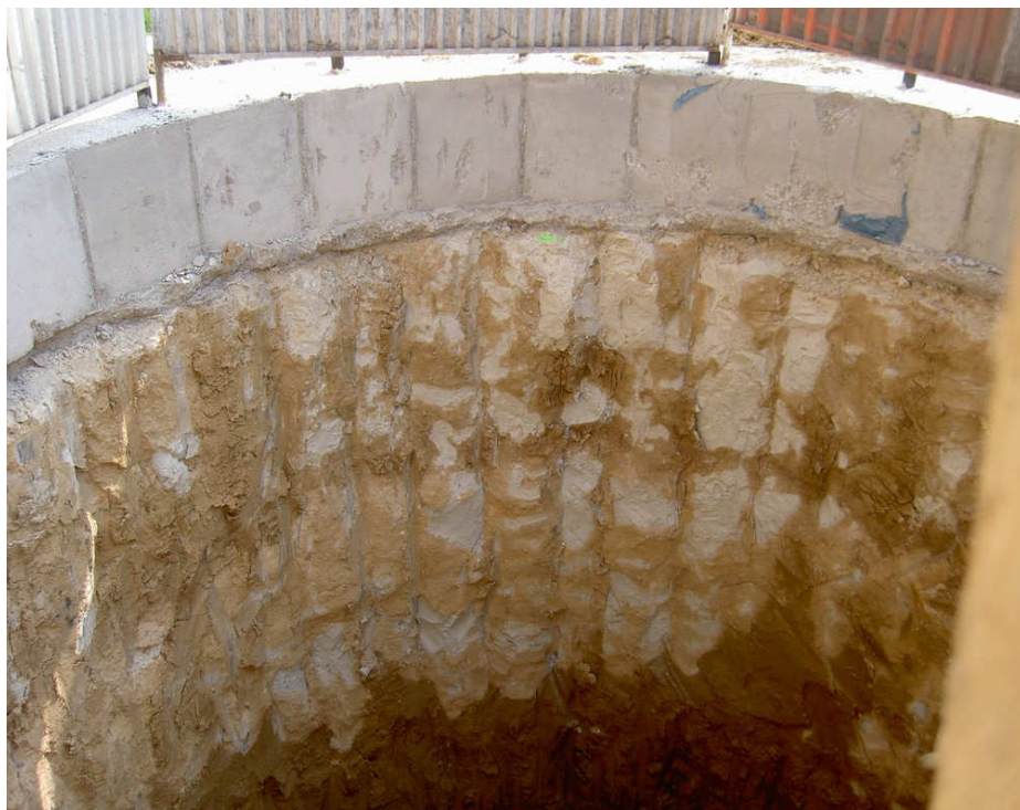
Vnitřní řada pilířů trykové injektáže kruhové šachty po odkopání
