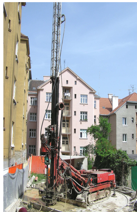
Provádění trykové injektáže – pažení kruhových šachet
