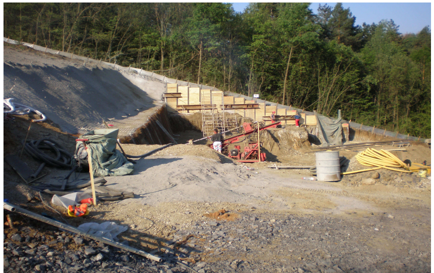
Provádění zemních hřebíků
