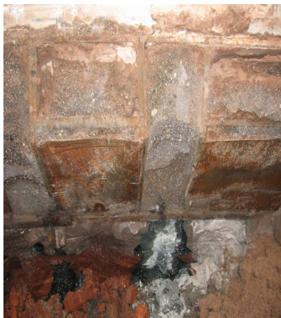
JG seal under shaft edge
