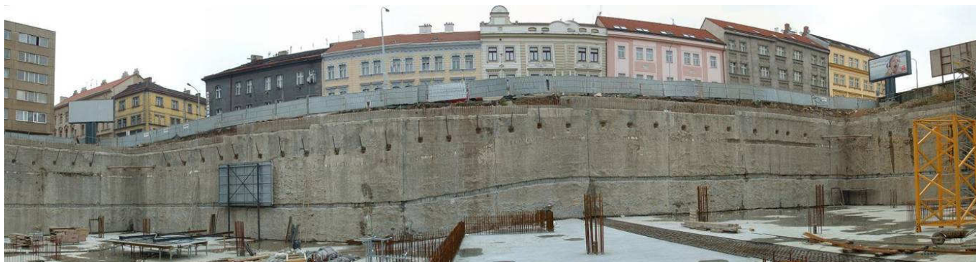
Pohled na kotvené podzemní stěny
