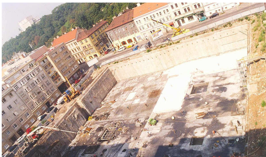
Zajištění stavební jámy
