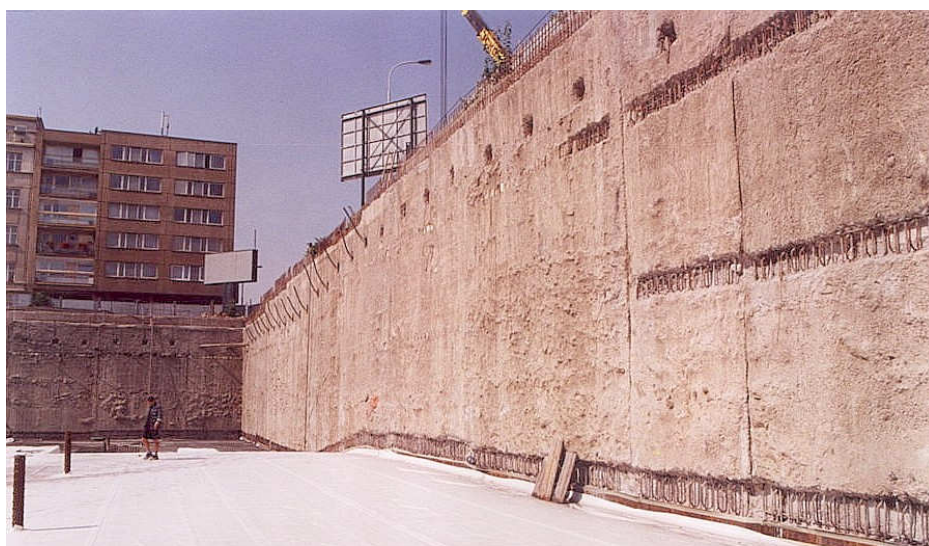
Pohled na kotvené podzemní stěny
