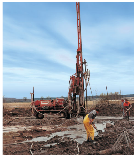
Výroba dělící stěny z tryskové injektáže ECOSOL ®
