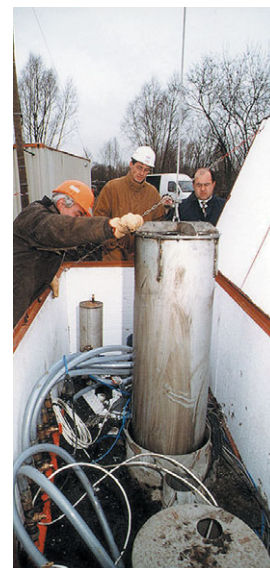
Výměna filtrů v reakční bráně
