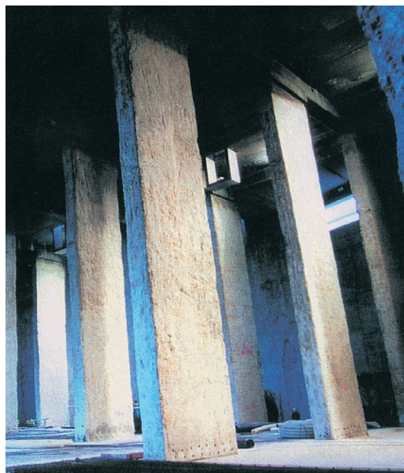
Využití elementů podzemních stěn v suterénních prostorách vodního díla
