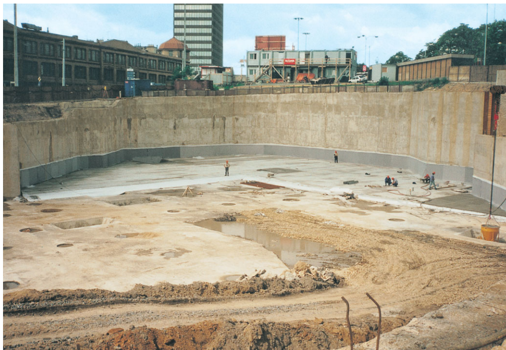
Pažená stavební jáma (Hotel Don Giovanni, Praha)
