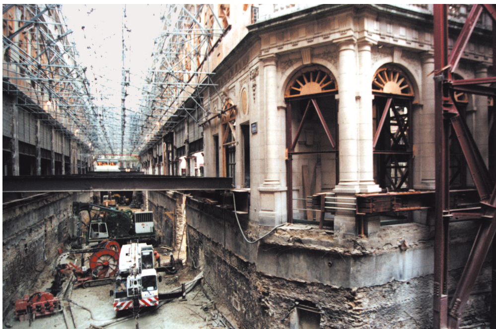
Výroba podzemních stěn – rekonstrukce uvnitř budov
