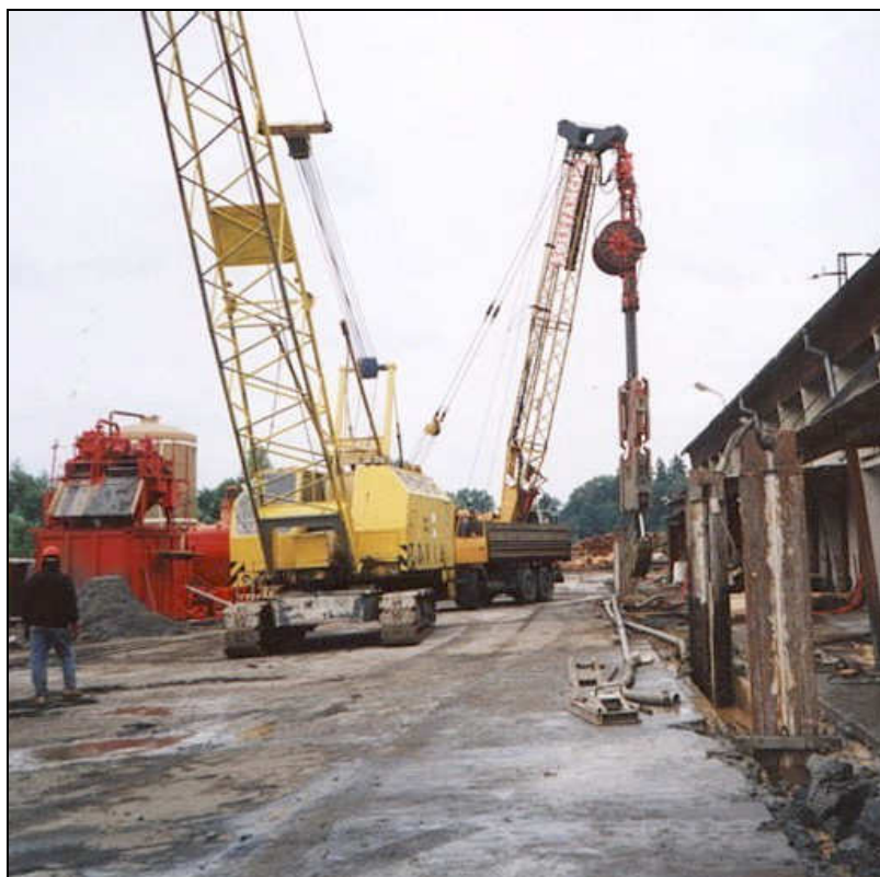
Pohled na výrobu podzemních stěn
