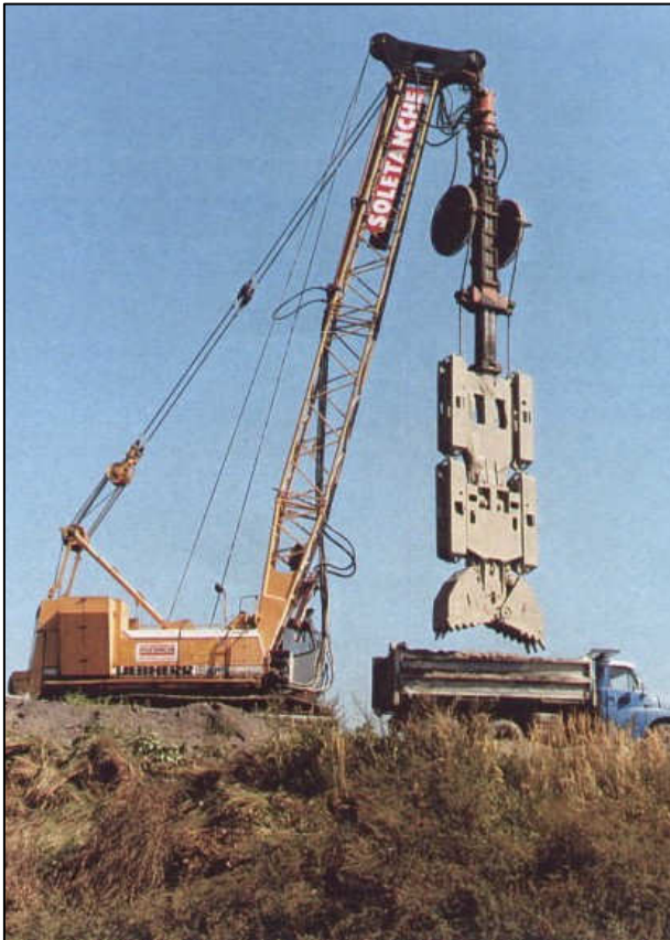
Hloubení podzemní těsnicí stěny
