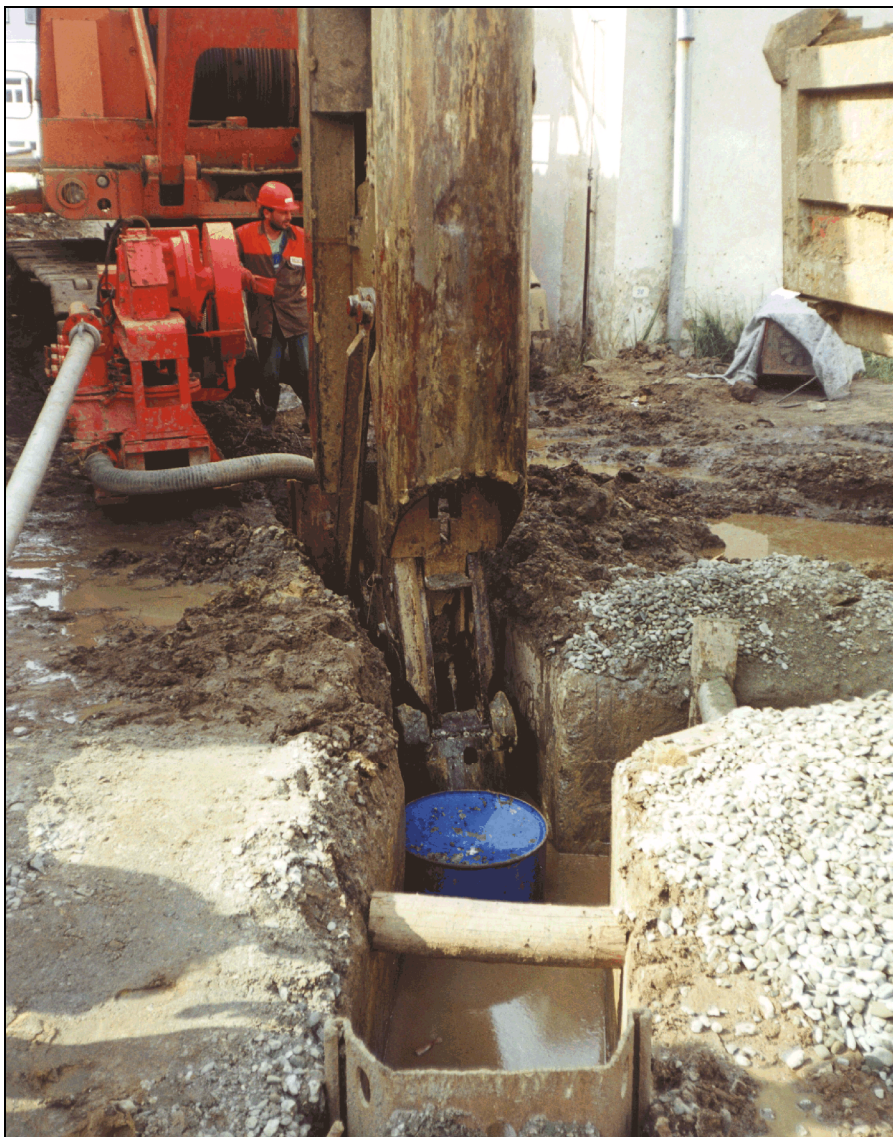
Detail realizace podzemní drenážní stěny pod ochranou biodegradovatelné pažící suspenze
