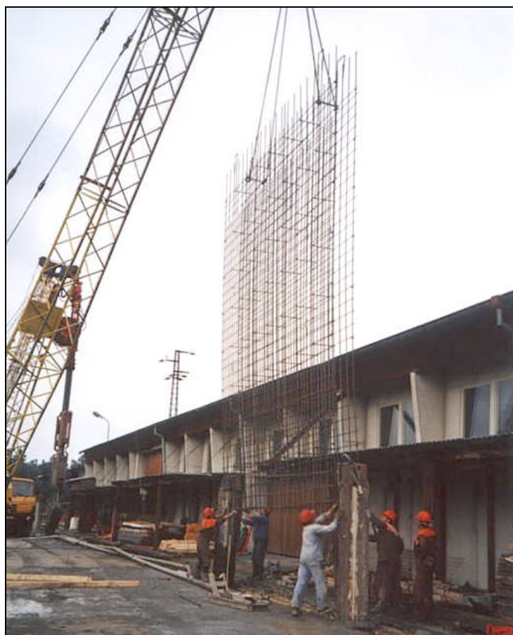
Osazování armokoše do rýhy
