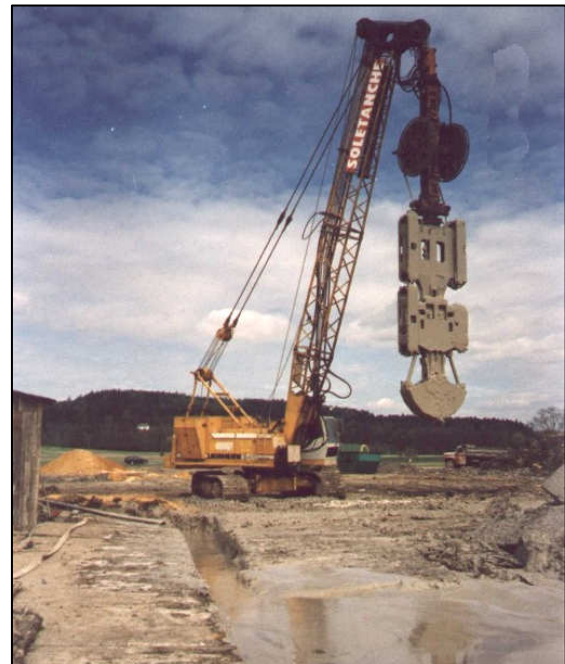
Realizace těsnící podzemní stěny
