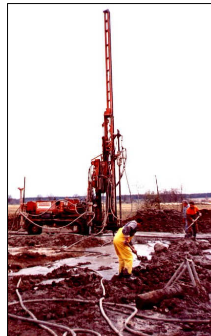
Výroba dělicí clony z tryskové injektáže
