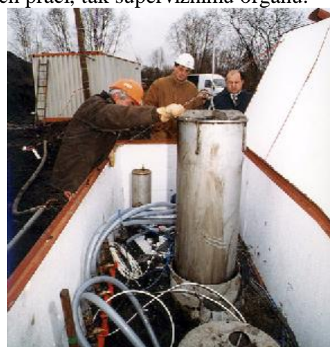
Obrázek 7: a) Auby - celkový pohled a reakční brána; b) Výměna filtrů
