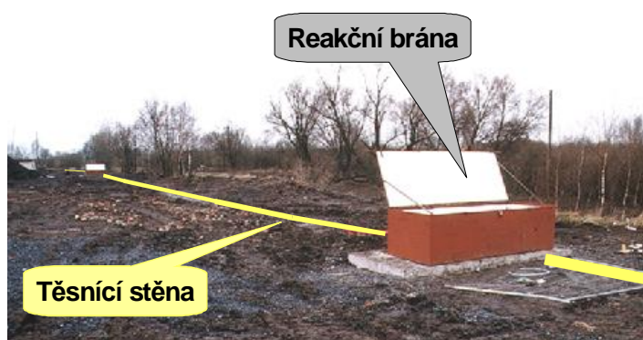
Obrázek 7: a) Auby - celkový pohled a reakční brána; b) Výměna filtrů
