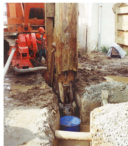
Realizace podzemní drenážní stěny pod ochranou biodegradovatelné pažící suspenze.
