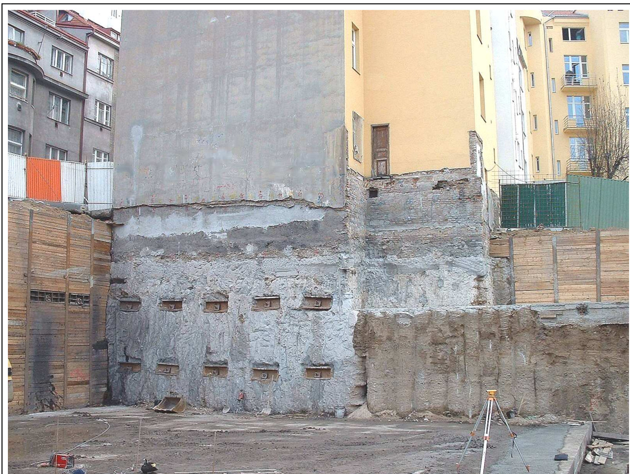
Obr. 9: Ukázka podchycení objektu pilíři tryskové injektáže (Praha).
