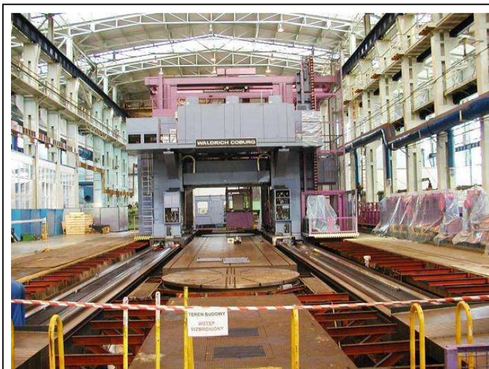
Obr. 3: Dvouportálová velmi přesná fréza založená na plošném základovém bloku 12 x 43 x 7 m.
