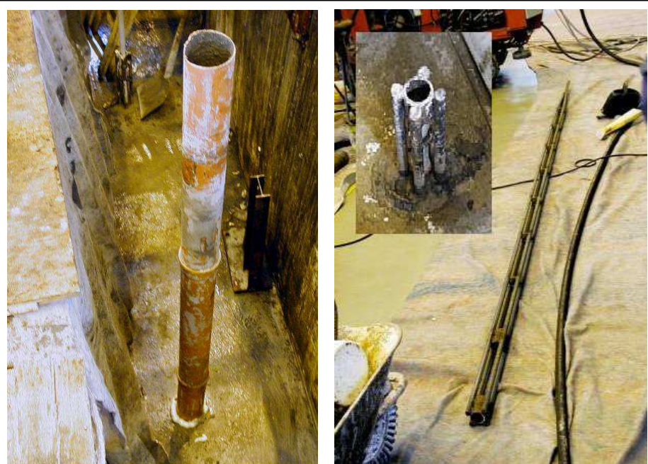
Obr. 6: Prodlužování vrtů nad HPV a ukázka miniarmokoše
