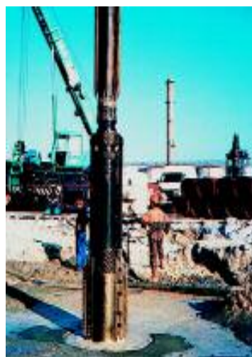
Proces vibroflotace
