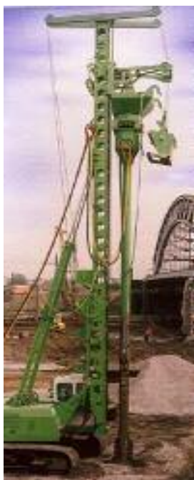
Provádění šterkových pilířů suchou cestou
