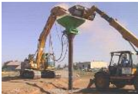
Provádění šterkových pilířů suchou cestou
