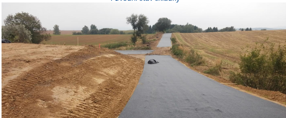
Zemní práce, zřízení přístupové komunikace
