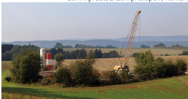
Realizace jílocementové podzemní těsnicí stěny
