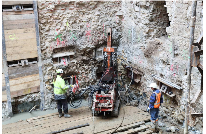
Probíhající vrtné práce
