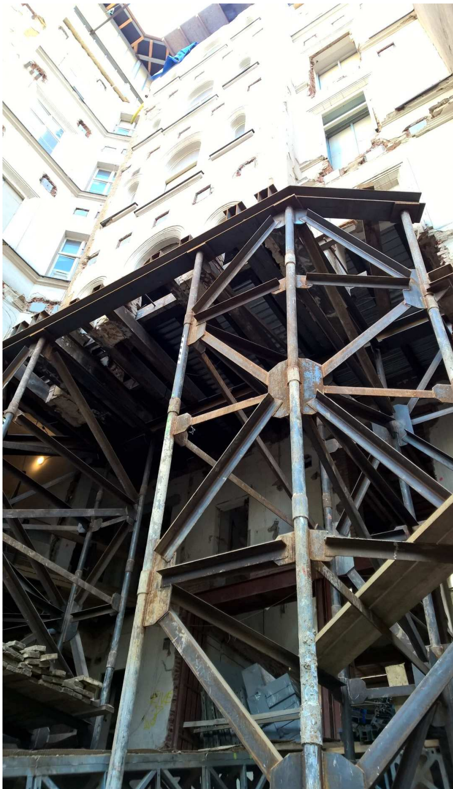
Podchycení objektu na ocelových mikropilotových bárkách
