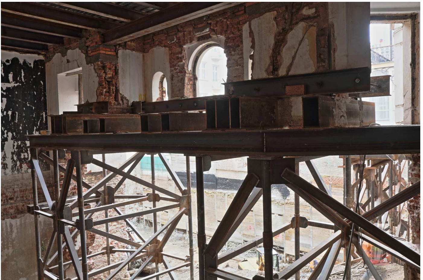
Zřízení nového dvoupruhového průjezdu do dvorního traktu za pomoci vynesení objektu na ocelových bářkách
