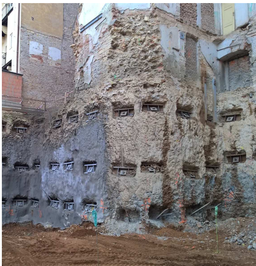
Dokončování výkopů, nanášení ochranné vrstvy stříkaným betonem a realizace kotevních prvků (osazování převážek)
