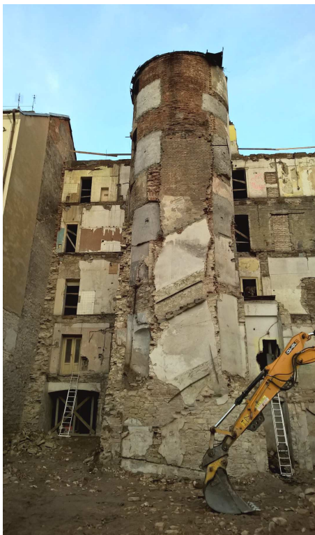
Schodišťová věž k podchycení (po odbourání okolní konstrukce, staticky ve špatném stavu)
