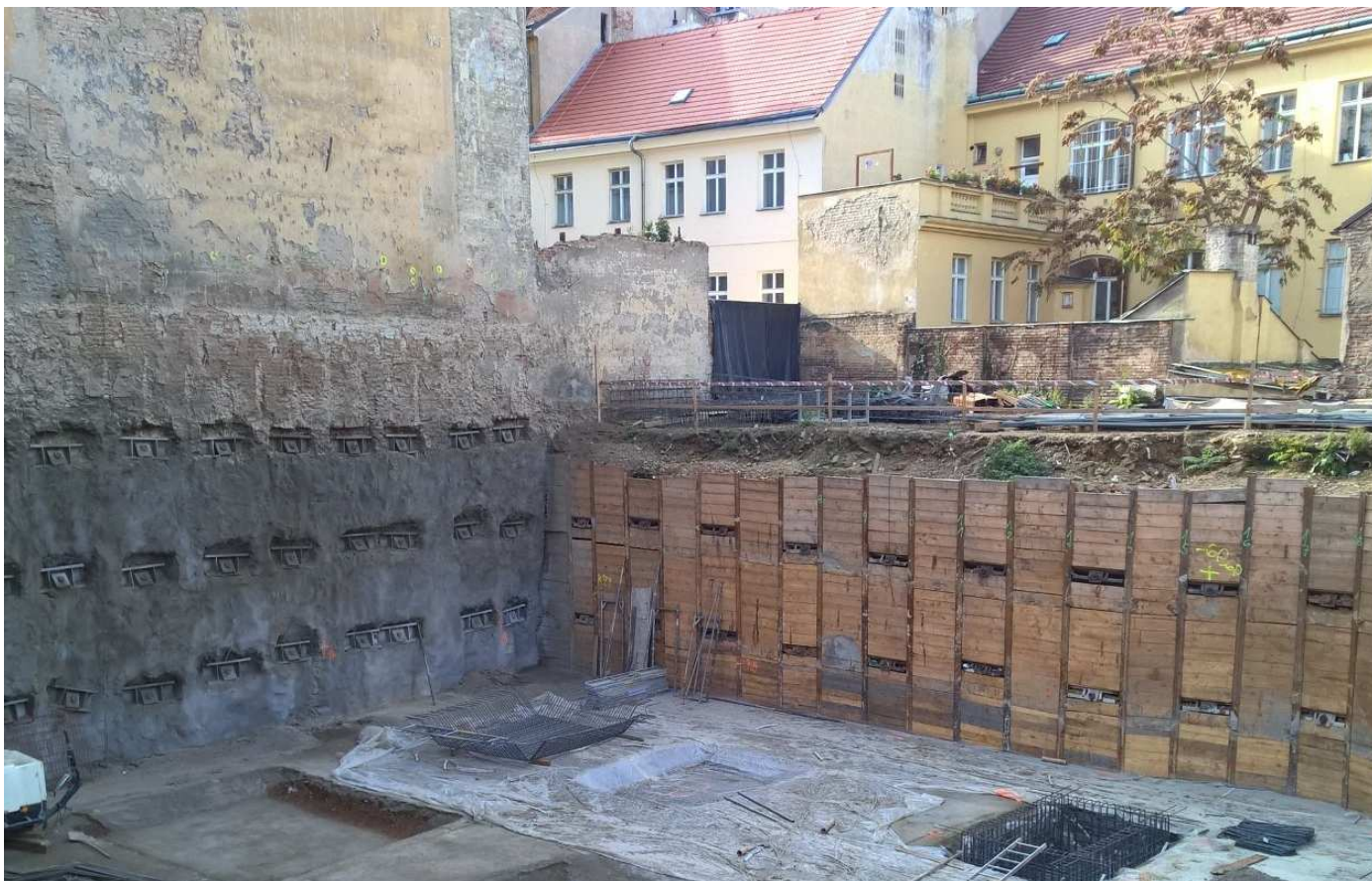
Kotvená pažící stěna z tryskové injektáže pod sousedními objekty a kotvená mikrozáporová stěna na hranici jámy bez objektů.
