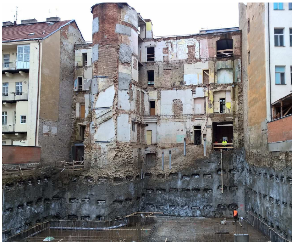
Podchycení schodišťové „věže“ kotvenou stěnou z tryskové injektáže. Hloubka jámy 7 m.
