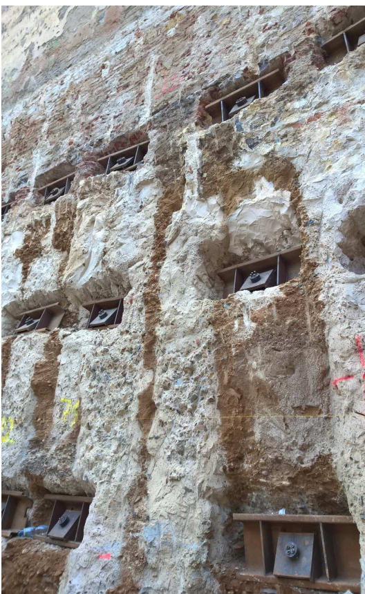
Detail kotvení a zapuštění do stěny z trysk. injektáže před nanesením povrch. úpravy stříkaným betonem.
