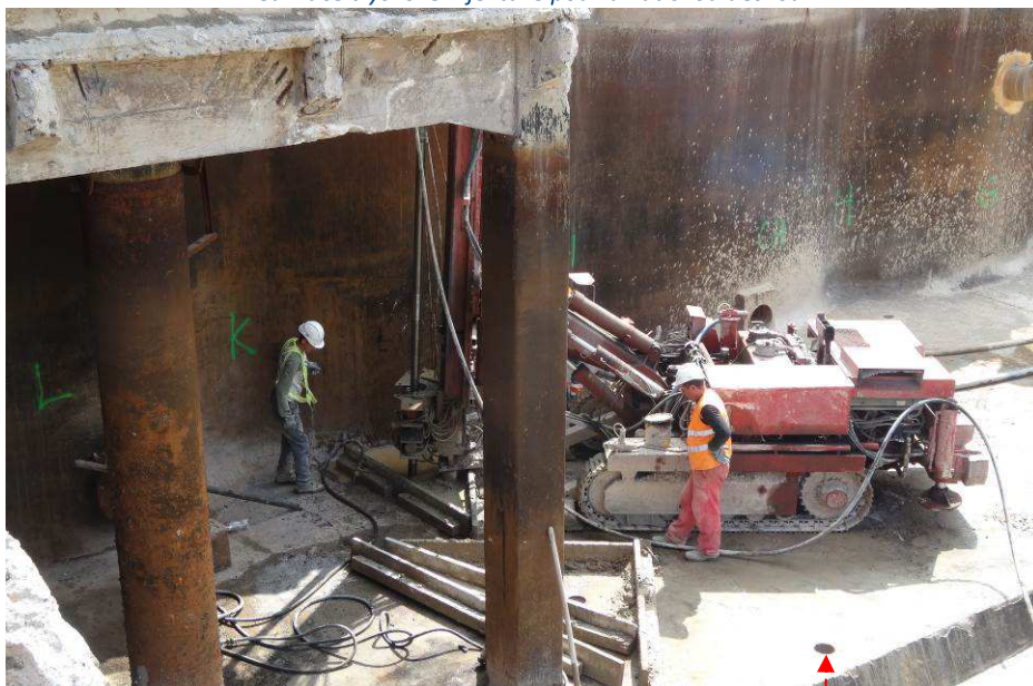
Realizace trykové injektáže pod základovou deskou
