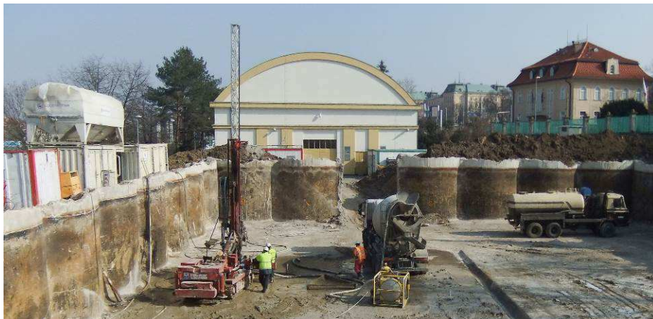
Realizace trykové injektáže pod základovou deskou
