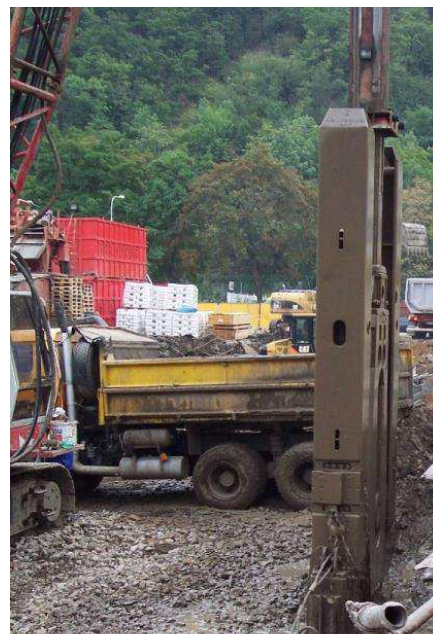
Provádění podzemních stěn:
