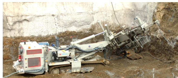
Kotvení podzemních stěn:
