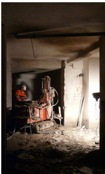
Provádění trykové injektáže
