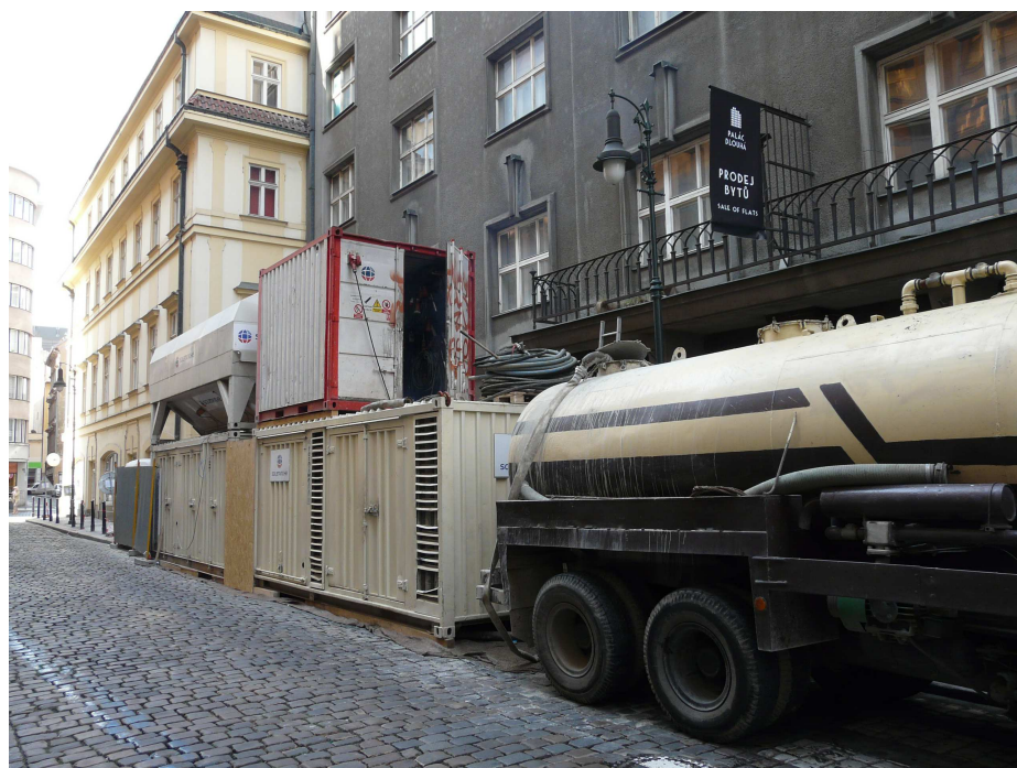
Zařízení staveniště na omezeném prostoru ulice před rekonstruovaným domem
