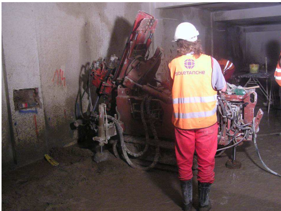
Provádění trykové injektáže
