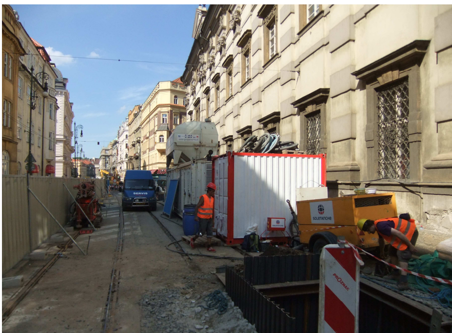
Technologické zařízení pro trykovou injektáž
