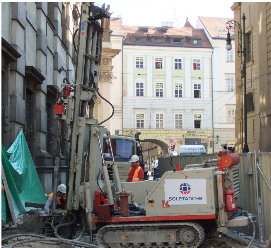
Provádění trykové injektáže
