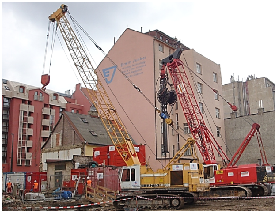
Provádění podzemních stěn
