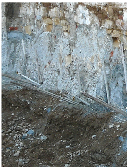
Podchycení tryskovou injektáží
