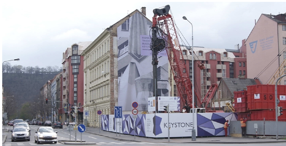
Provádění podzemních stěn
