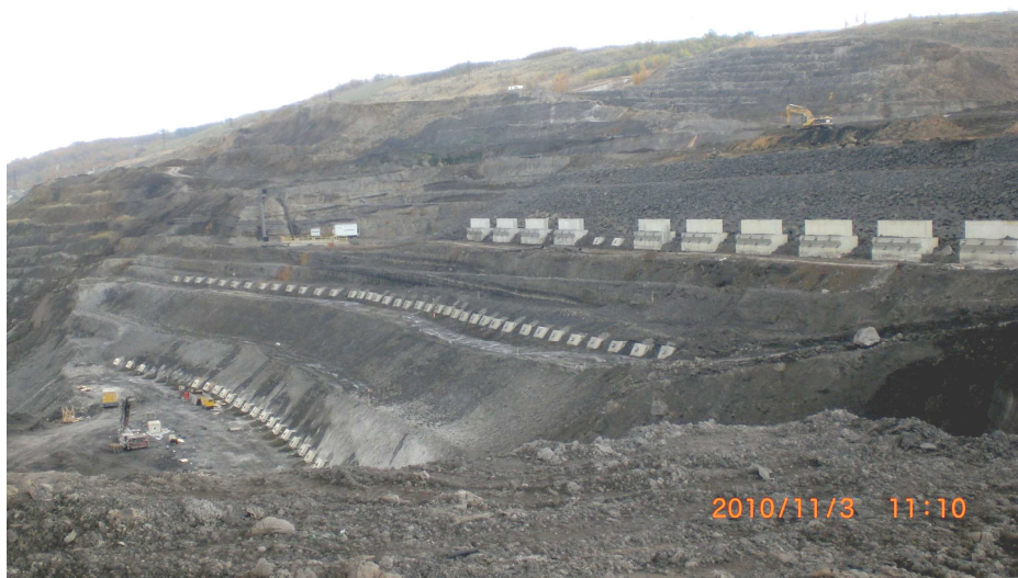
Pohled na trvalé kotvené železobetonové bloky
