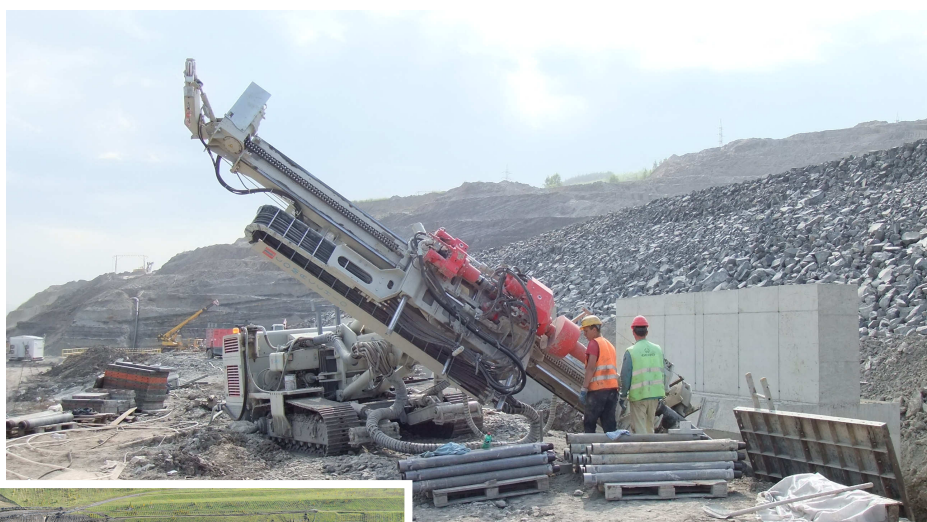
Provádění kotev
