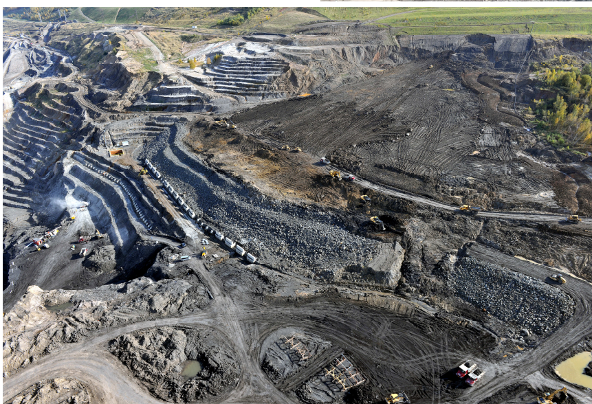
Letecký pohled na zajištěný svah
