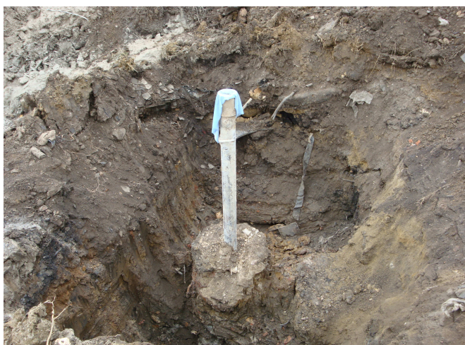
Mikropilota zesílená trykovou injektáží
