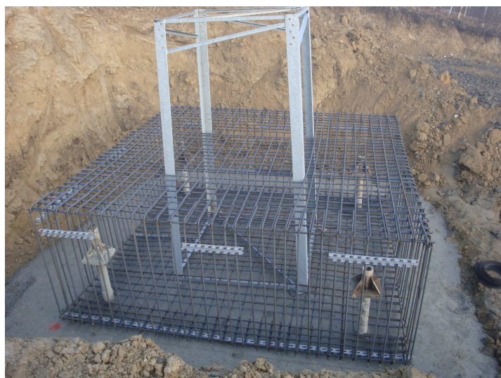
Základová patka před betonáží
