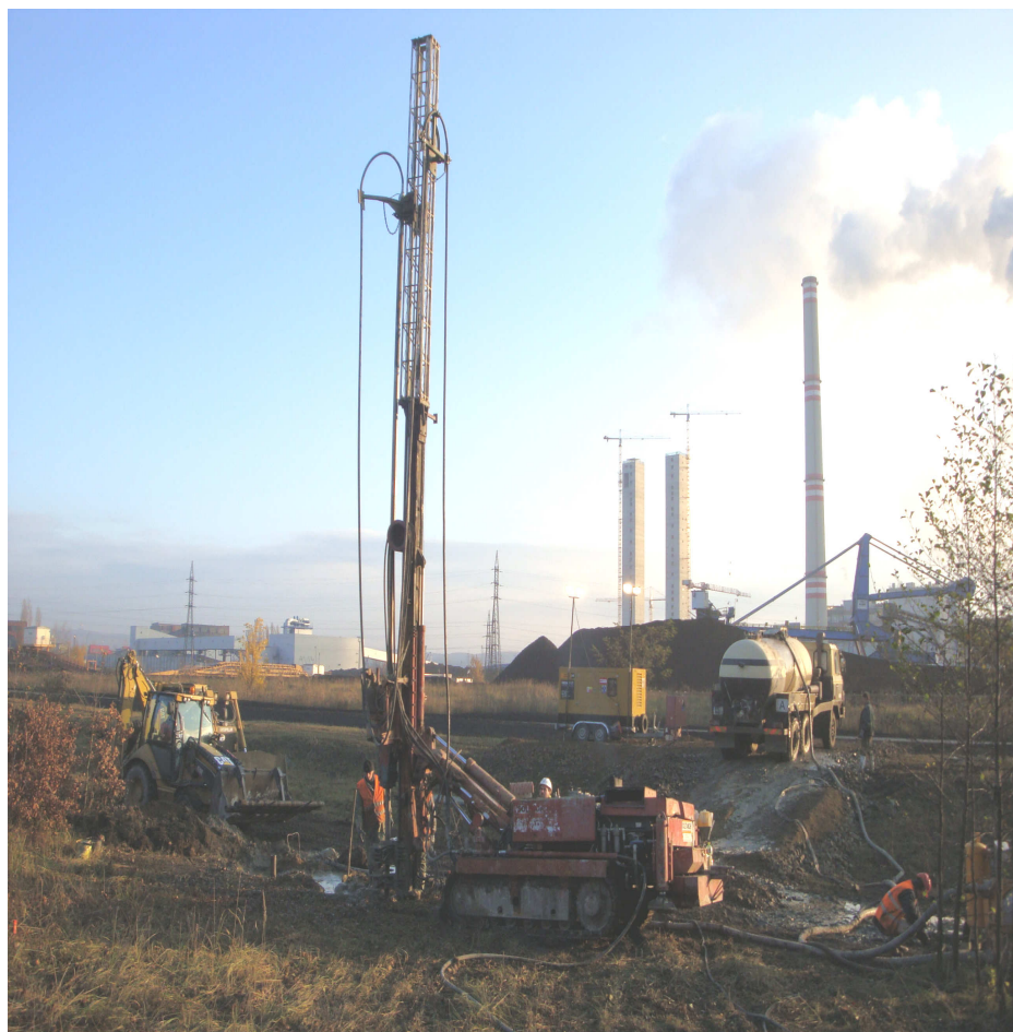
Provádění trykové injektáže
