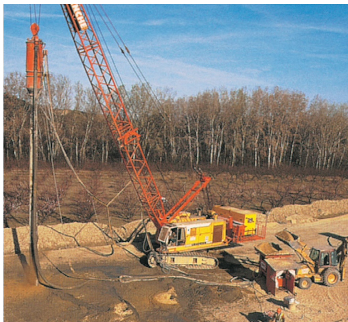
Provádění štěrkových pilířů
