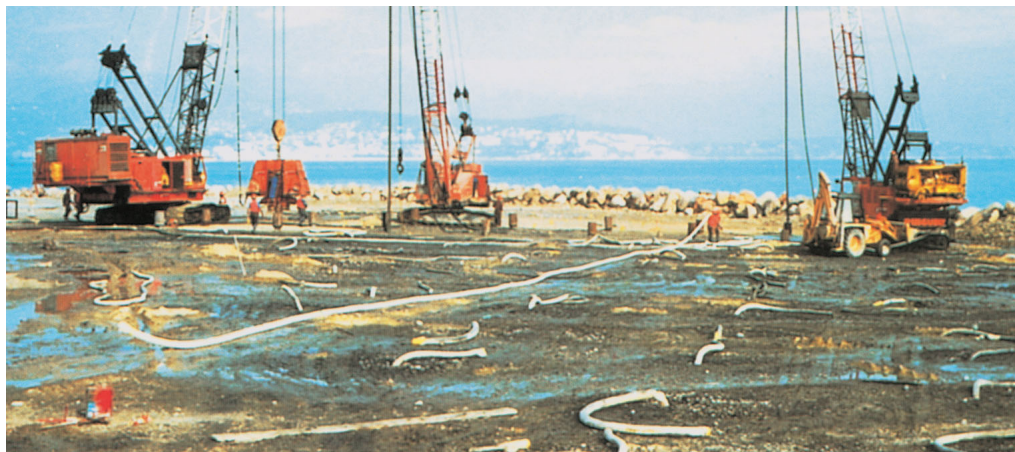
Provádění vertikálních drénů
