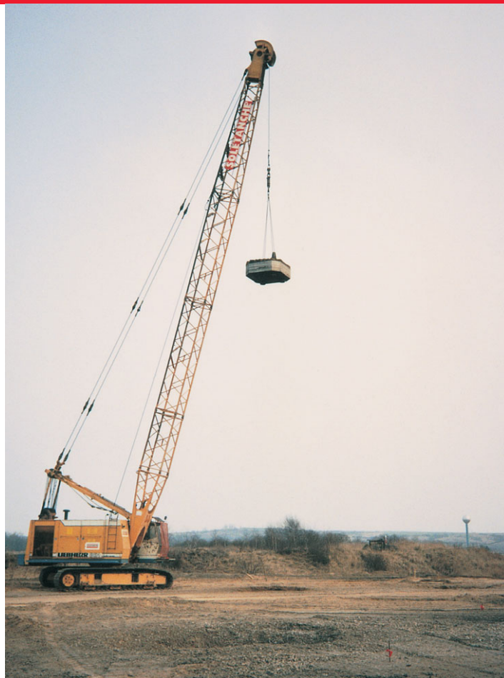
Provádění dynamické konsolidace na skládce SPOLANA Neratovice.
