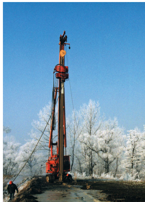
Úpravy protipovodňových hrází tenkými podzemními stěnami.
