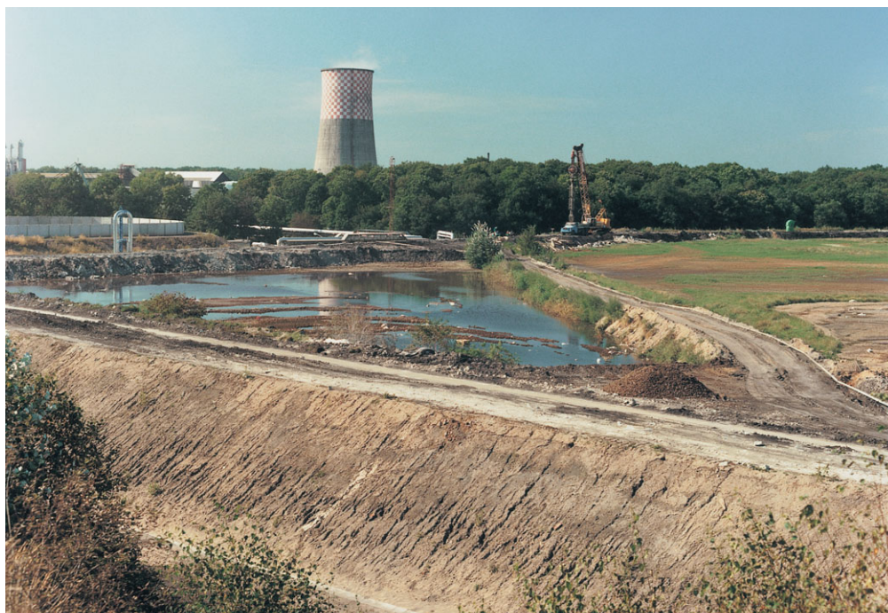
Sanace toxické skládky podzemní těsnící stěnou ECOSOL® (Spolana Neratovice)
