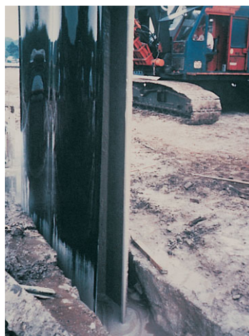
Instalace pásu geomembrány
