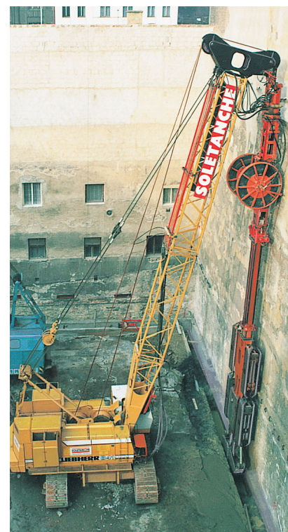
Hydraulický drapák při těžbě
