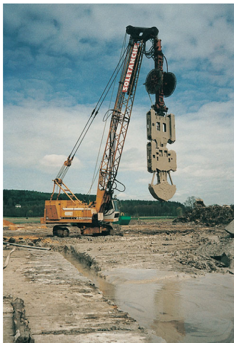
Geokontejnment skládky těsnící podzemní stěnou (Kema – Skalná).
