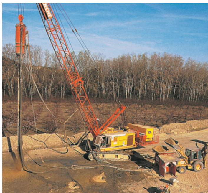
Provádění štěrkových pilířů
