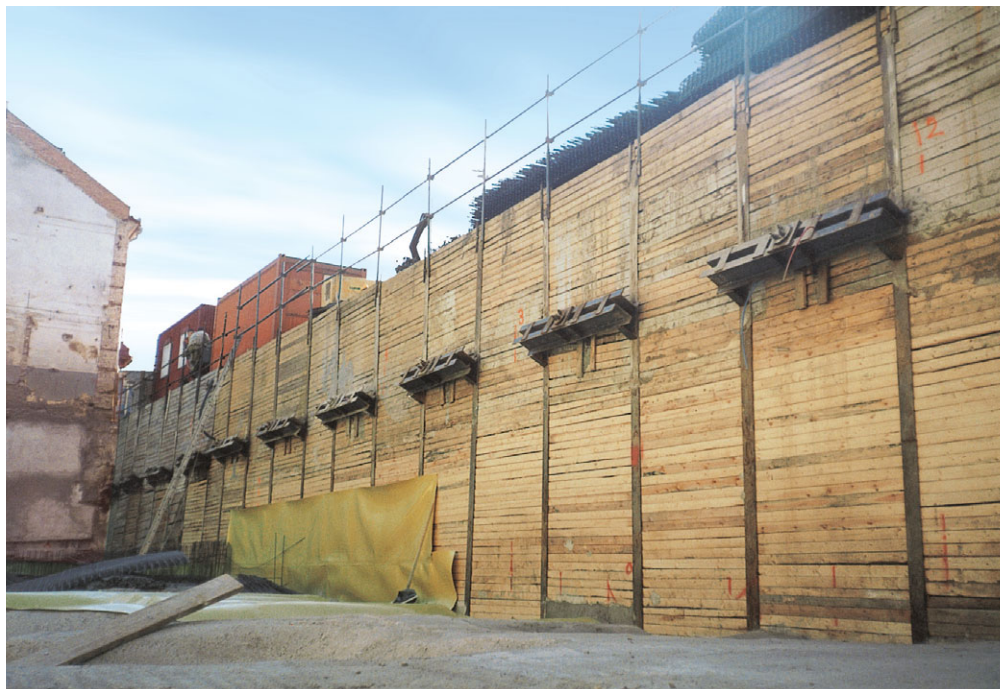
Ukázka kotvené záporové stěny (Pod Kotlaskou, Praha)
